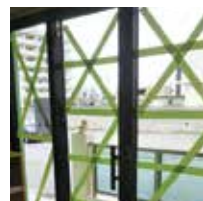
台風接近 ガラスに養生テープ
